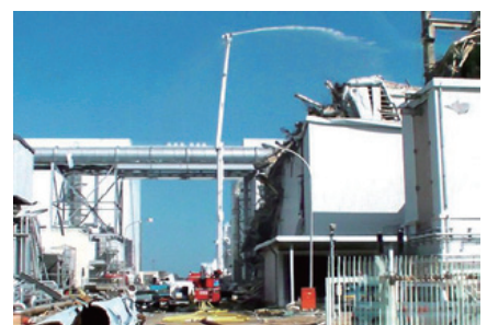
東京電力福島第一原子力発電所3号機への放水（東京消防庁提供）
