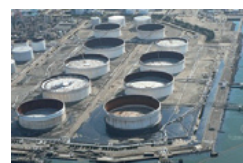
津波により屋外タンク貯蔵所の配管が破損しタンク内の危険物が流出した状況 (仙台市消防局提供)
