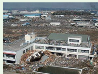
中野小学校屋上の状況 (全国消防長会提供)
