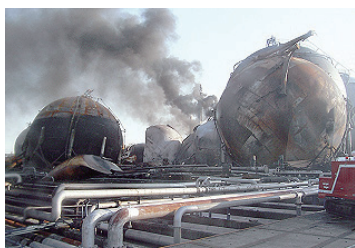
火災により液化石油ガスタンクが倒壊 (千葉縣市原市 川崎市消防局提供)
